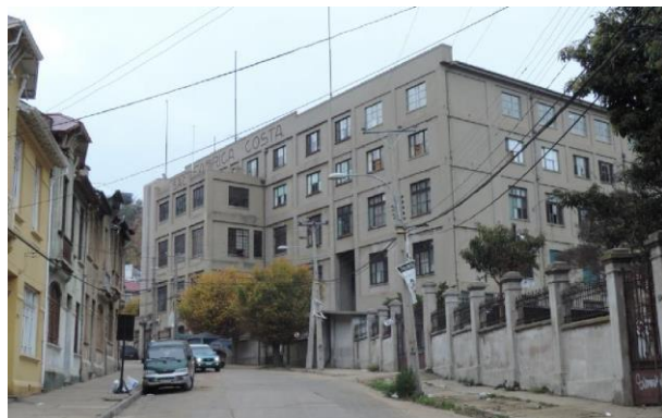
ex Fábrica en calle Costa Santa Elena
